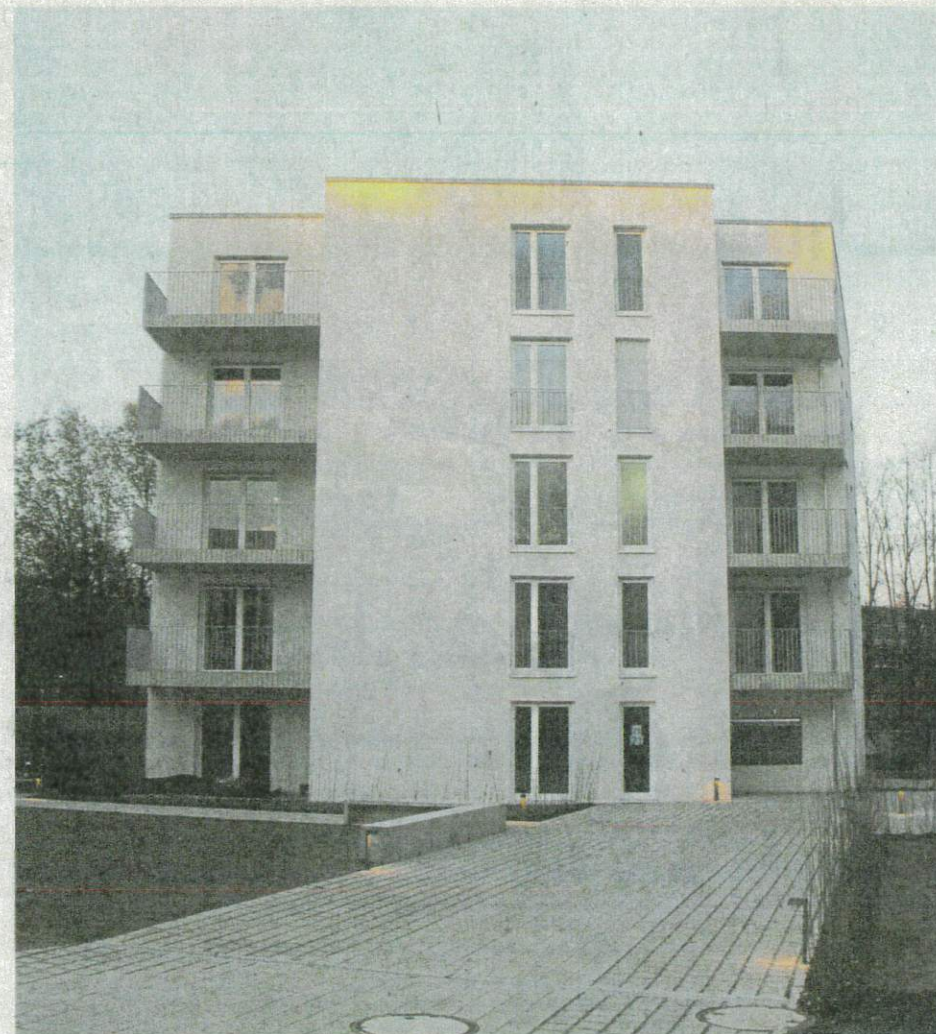
Dieses Mehrfamilienhaus der Baugenossenschaft im Gebäudeensemble „Parque Monterey“ (Königsberger Straße) steht vor der Fertigstellung. Foto: Henning Zorn
