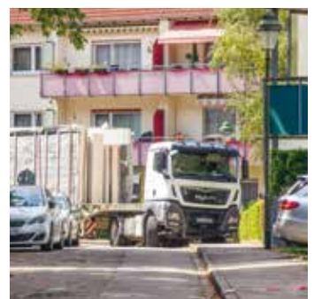
Anlieferung der Wandelemente
